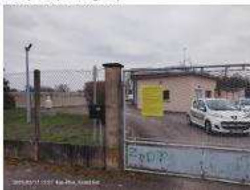
PHOTO 5 (Station d'apurement de Felsheim)
