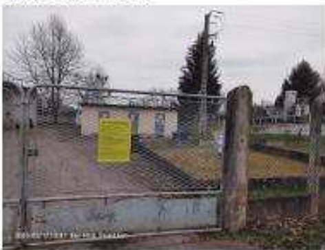
PHOTO 3 (Station d'apurement de Felsheim)
